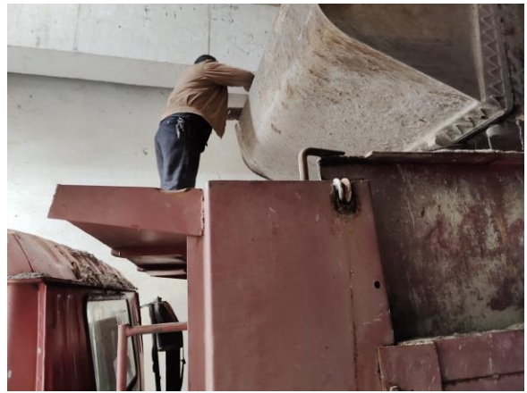
1#焚烧炉炉渣（■2）固体废物
