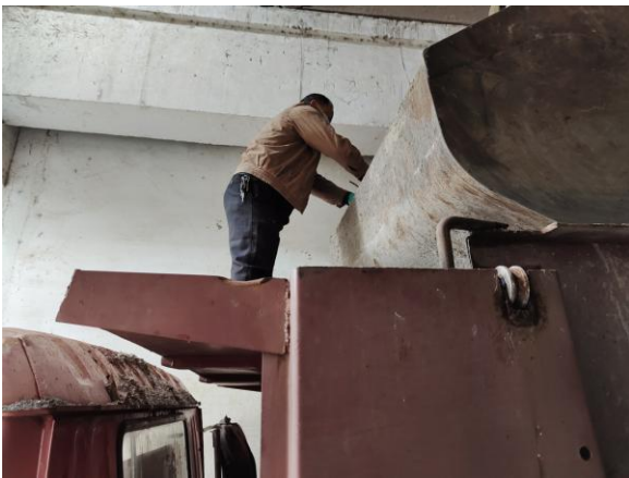
2#焚烧炉炉渣（■3）固体废物
